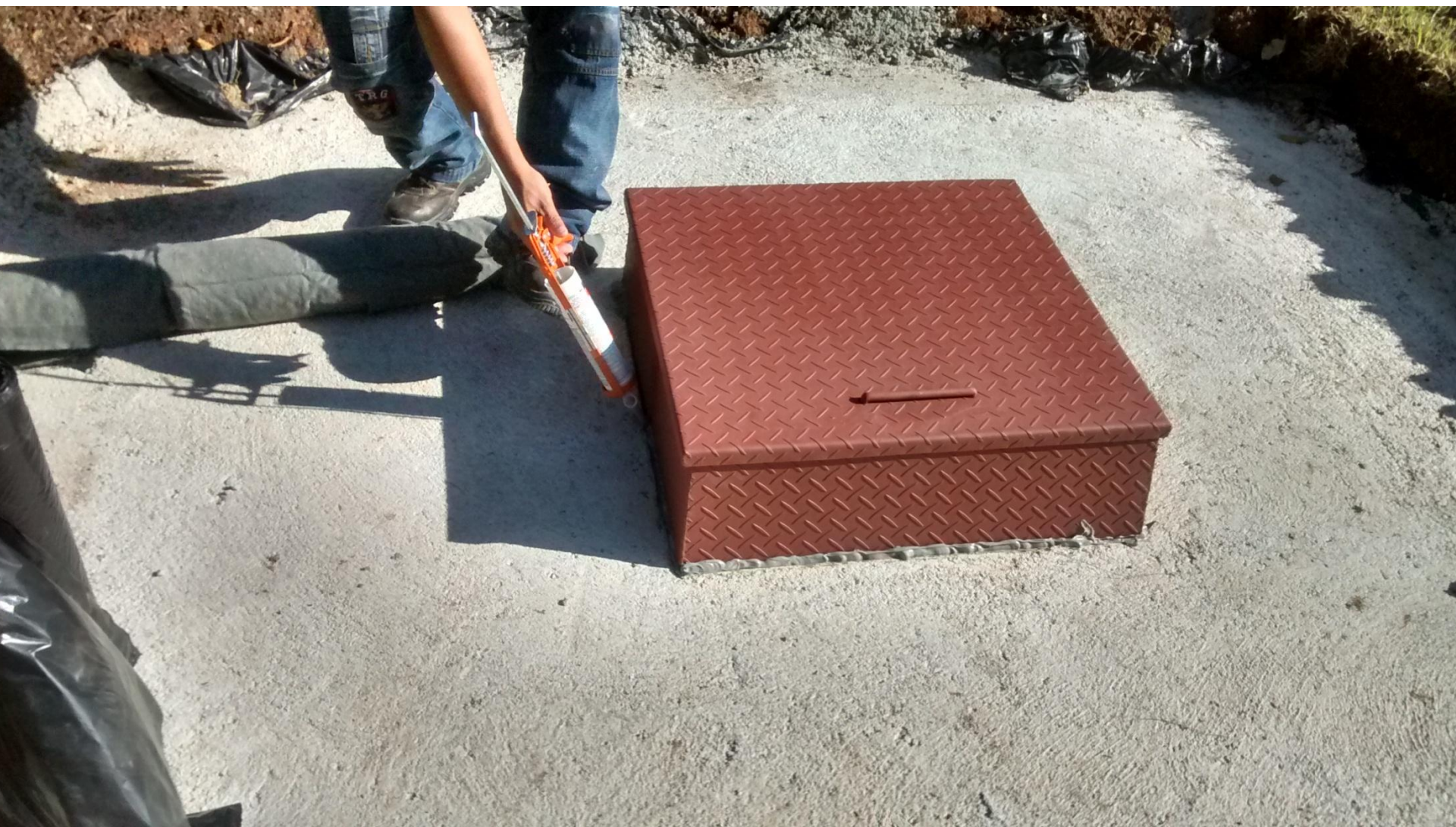
Instalação da caixa de acesso à cisterna
