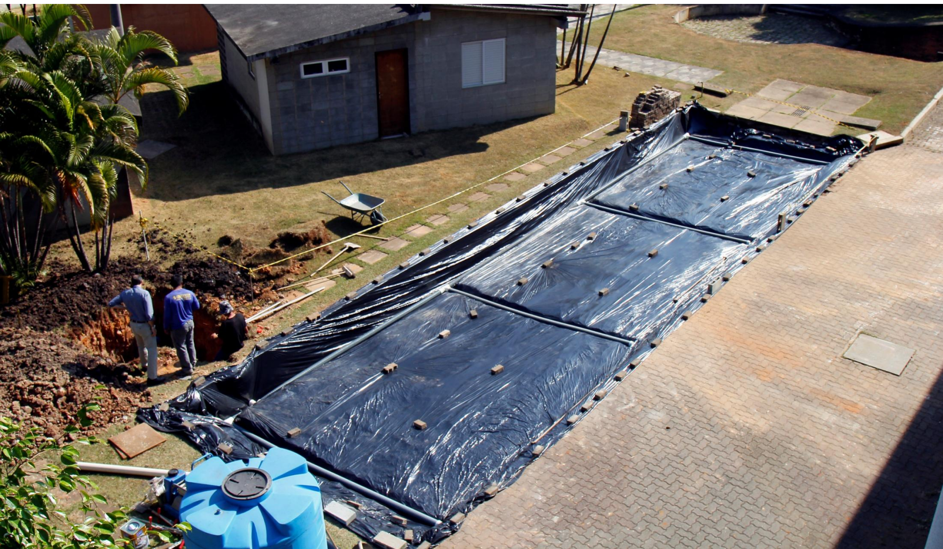
Vista geral da área após colocação da manta e dos tubos drenos
