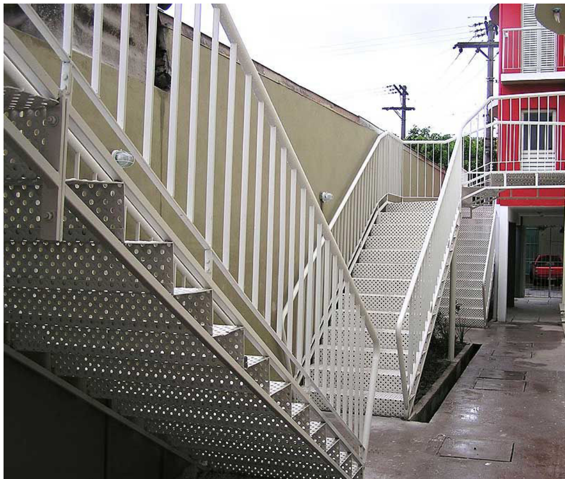
Acesso ao pavimento superior é feito a partir de escadas externas perfuradas, em ferro galvanizado a fogo para evitar ferrugem, (Foto: Divulgação - Bacco Arquitetura)
