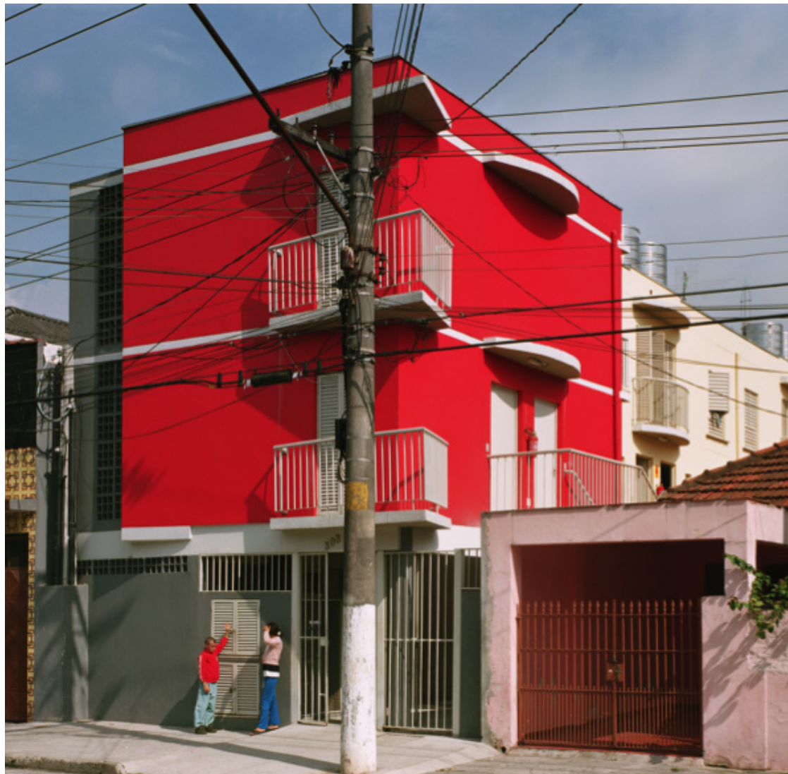
Vista da fachada da COHAB Pedro Facchini: prédio substituiu antigo cortiço e proporcionou dignidade aos moradores (foto: Nelson Kon – Divulgação Bacco Arquitetura)
