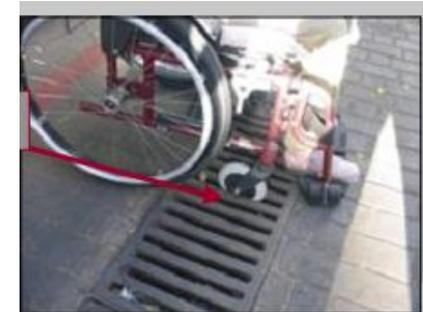
As tampas e grelhas devem ser niveladas pelo piso da calçada, sendo os ressaltos ou juntas de dilatação embutidos no piso, transversalmente no sentido do caminho.
