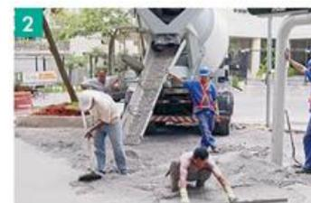
2 Lançamento, espalhamento e nivelamento (sarrafeamento) do concreto.
