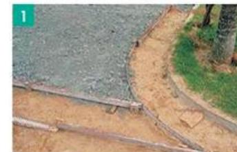
1 Nivelamento e compactação do subleito, colocação de brita, instalação das fôrmas e telas de aço.
