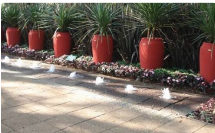
Casa Cor 2006 / São Paulo Lançamento do piso de placa pré moldada de concreto drenante. Projeto do arquiteto paisagista Benedito Abbud.
