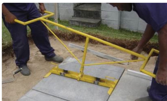
Assentamento das placas de concreto utilizando o saca-placas
