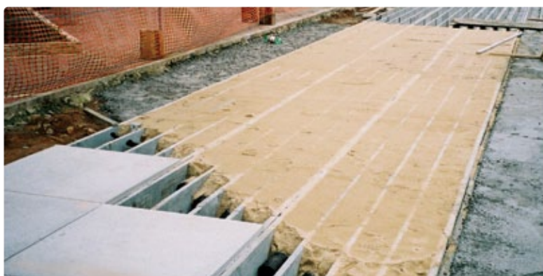
As placas também podem ser utilizadas como piso elevado externo.
