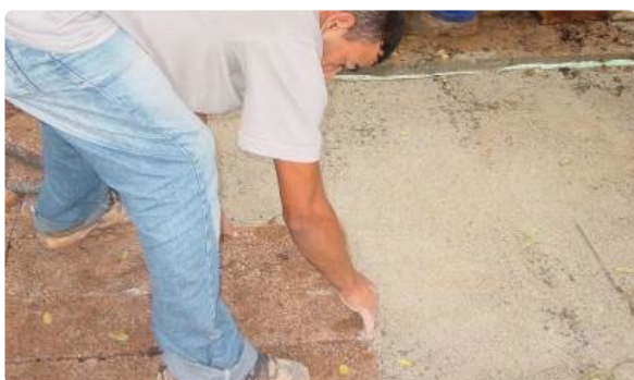
Assentamento das placas de concreto.
