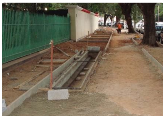
Espalhamento da brita
