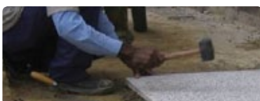
Assentamento das placas
