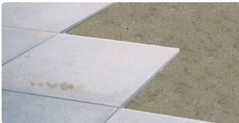
Placas assentadas em material granular - sistema flutuante
