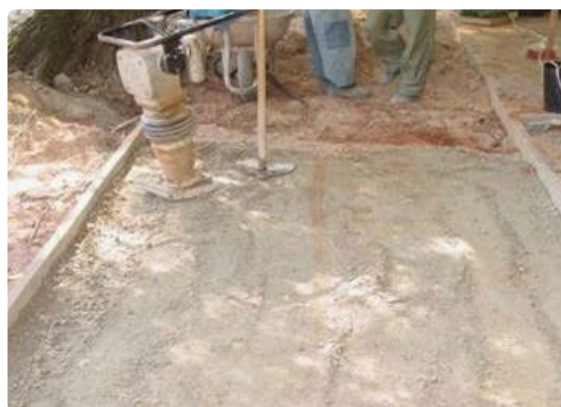
Compactação da brita
