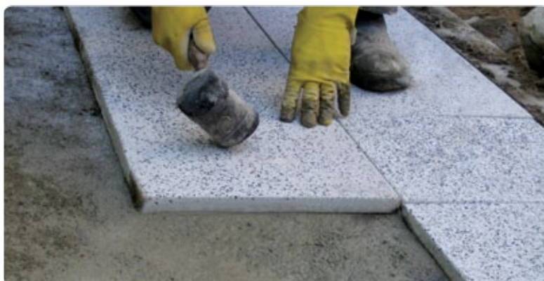
Placas assentadas sobre argamassa - sistema aderido
