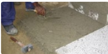
Colocação da placa de concreto
