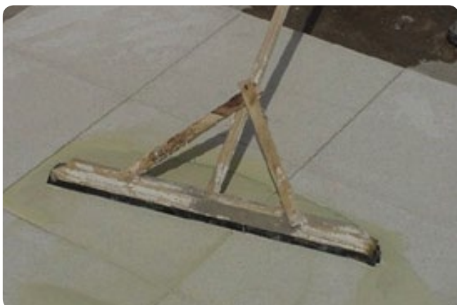
Rejunte - Quando especificado em projeto
