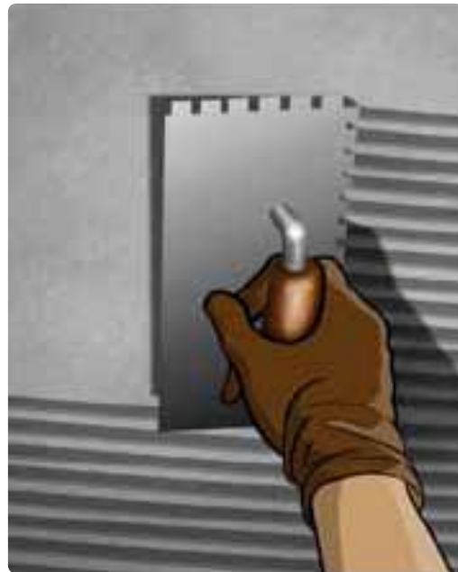
Raspagem com desempenadeira metálica
