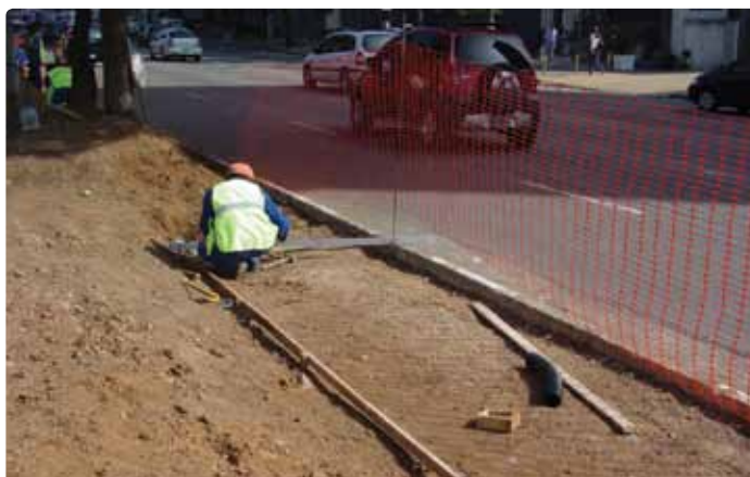
Barras de contenção de madeira
