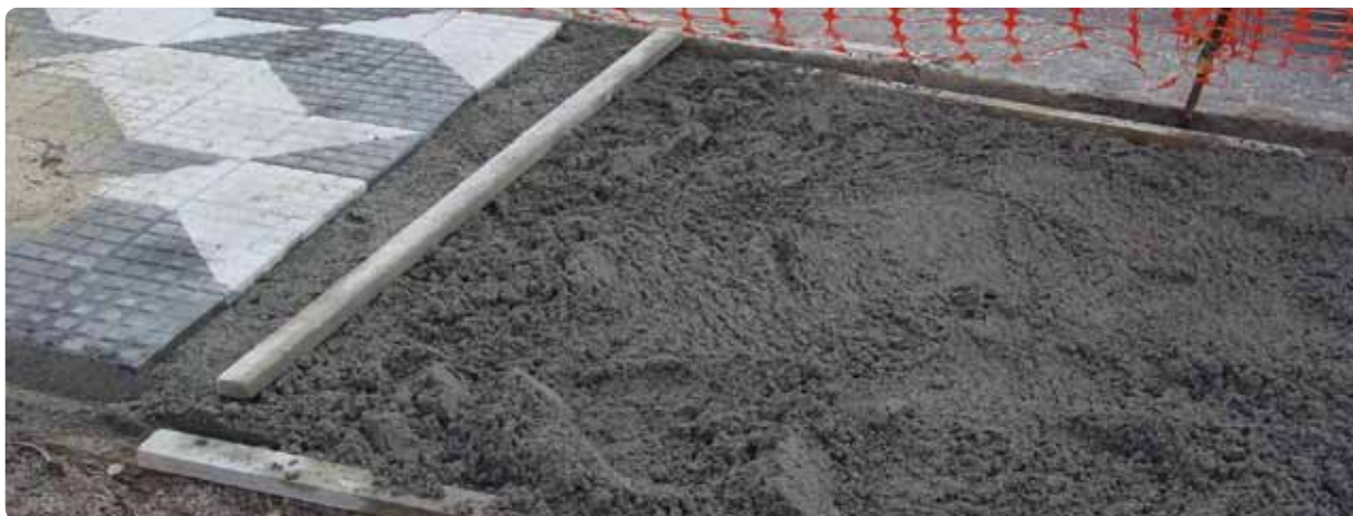
Assentamento utilizando argamassa tradicional
