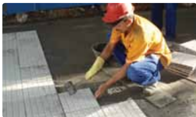
Assentamento do ladrilho hidráulico
