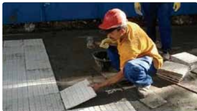
Colocação do ladrilho hidráulico
