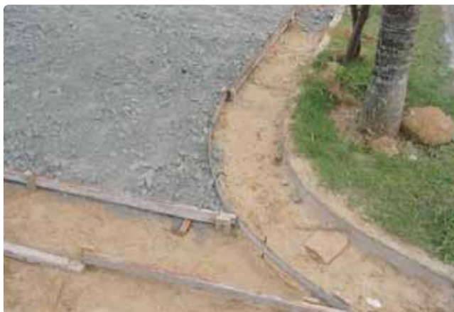
Fixação das fôrmas de madeira
