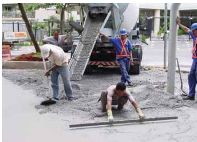
Recebimento e espalhamento do concreto
