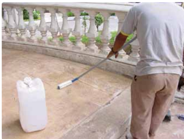
Aplicação de resina
