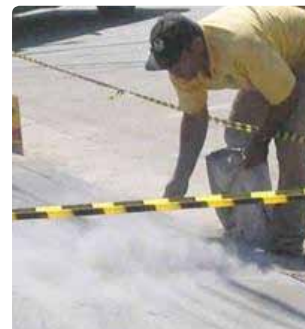
Lançamento do desmoldante
