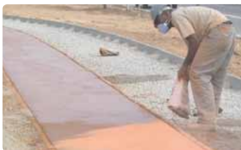
Lançamento do pó endurecedor de superfície
