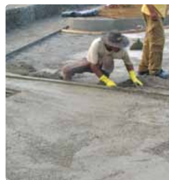
Sarrafeamento do concreto
