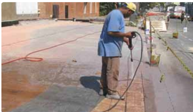
Retirada do desmoldante
