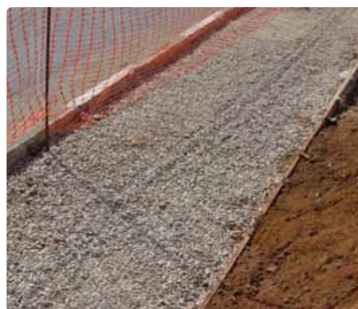
Espalhamento da camada de brita graduada
