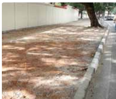
Nivelamento e compactação do terreno
